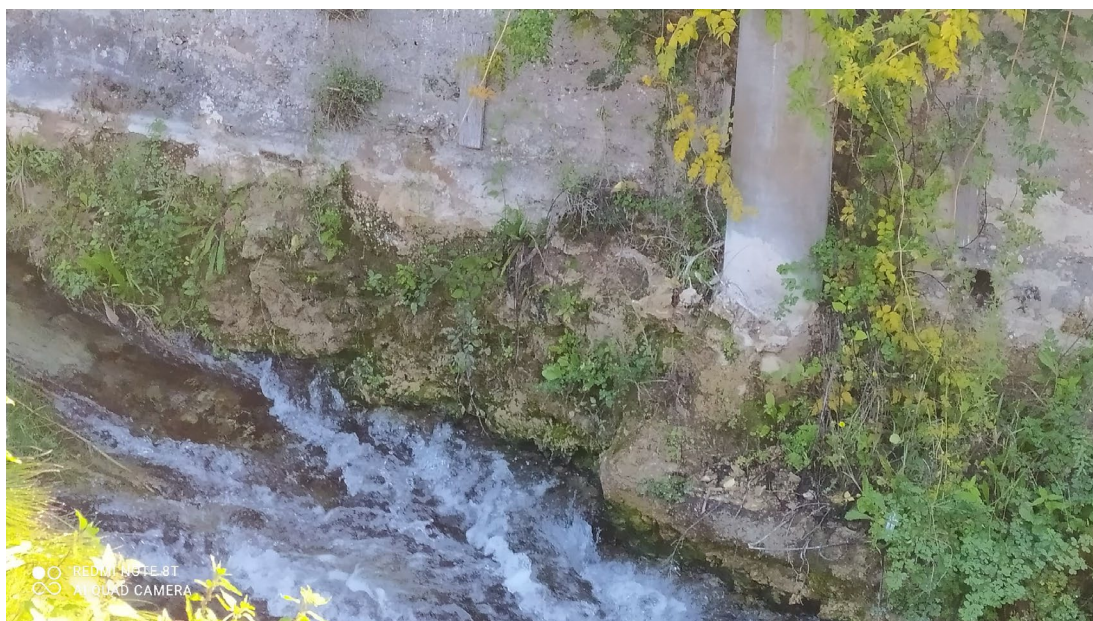
Tratto finale dell'area di intervento dove sulla sponda in sinistra orografica i muri di recinzione poggiano direttamente sul travertino
